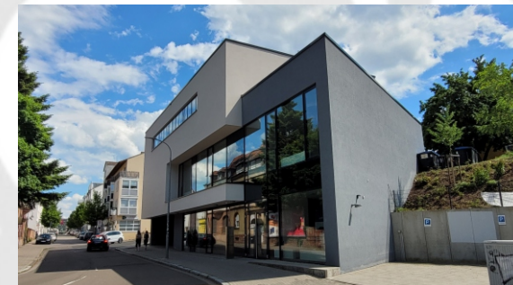
Seminargebäude der TAS in der Mühlstraße 47
