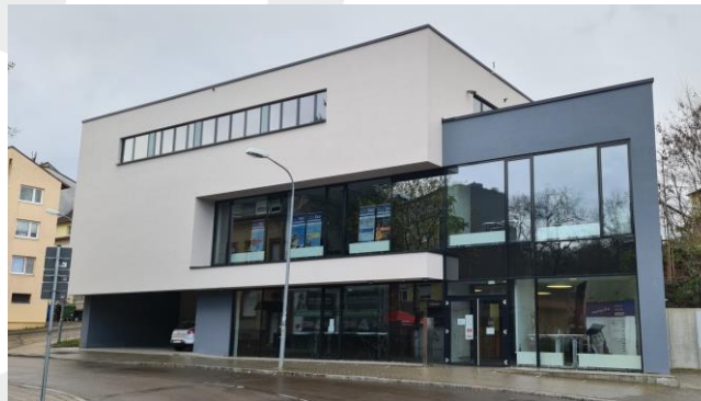
Seminargebäude der TAS in der Mühlstraße 47
